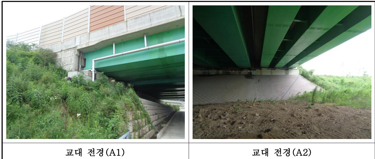
【사진 23.3.8】 교대 전경
