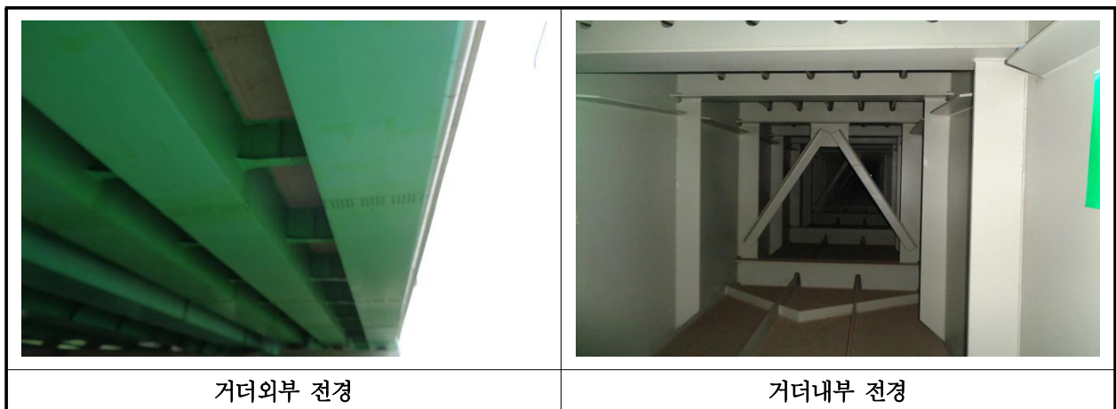
【사진 23.3.4】 거더 전경
