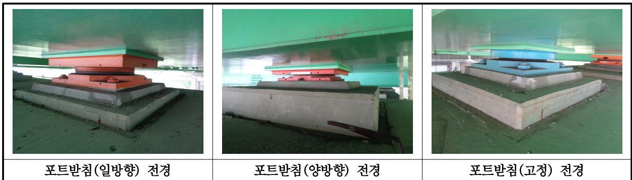
【사진 23.3.12】 교량받침 전경
