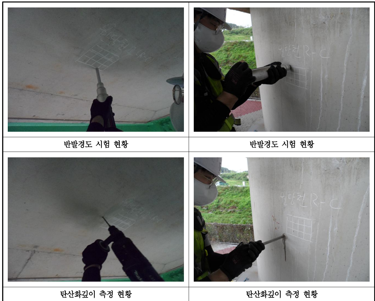
【사진 23.4.1】 콘크리트 내구성조사 현황
