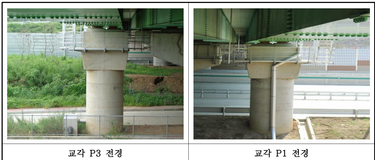
【사진 23.3.10】 교각 전경
