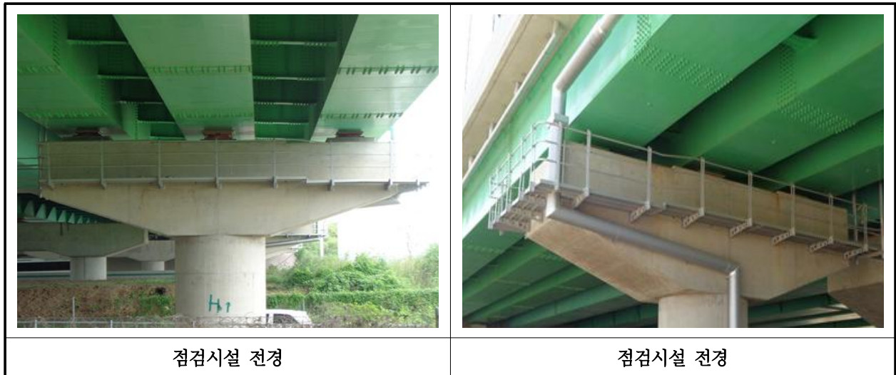
【사진 23.3.25】 교량 점검시설 전경
