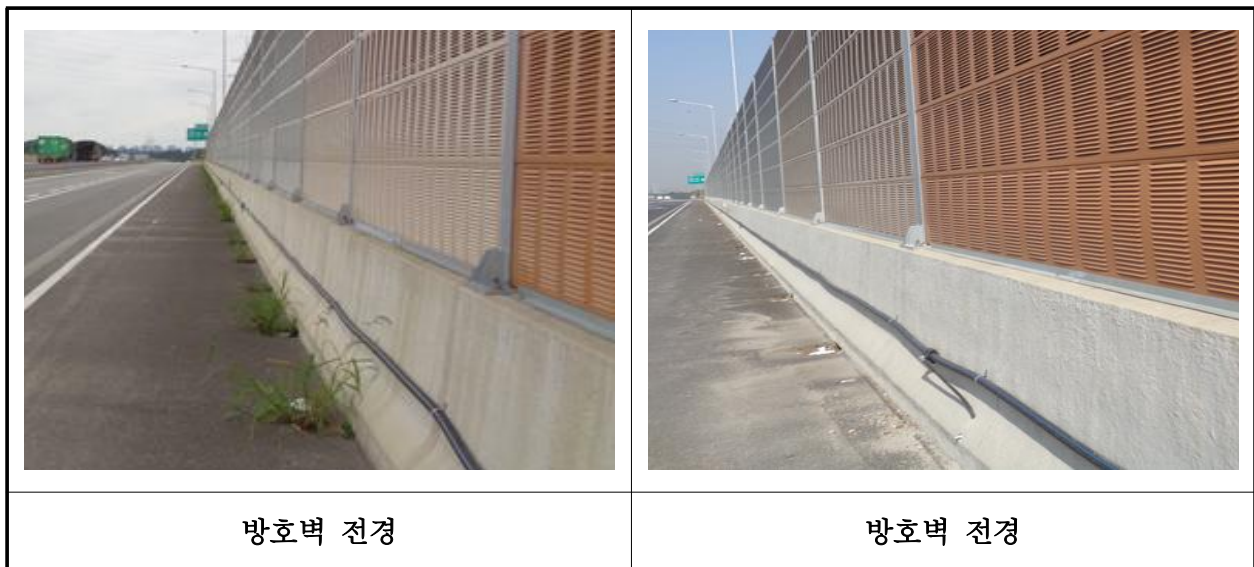
【사진 23.3.23】 방호벽 전경
