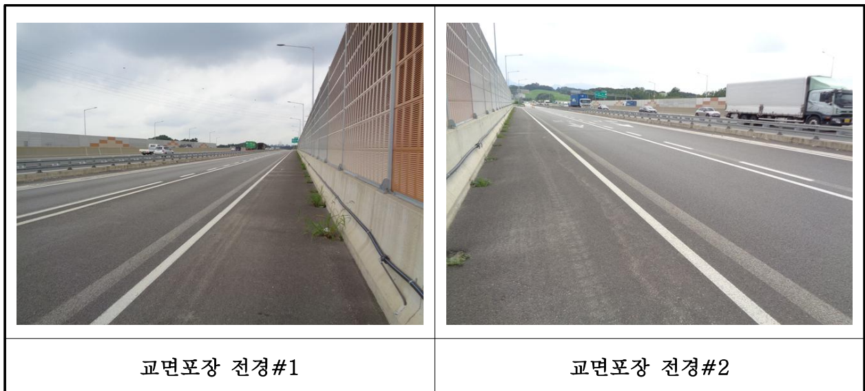
【사진 23.3.19】 교면포장 전경
