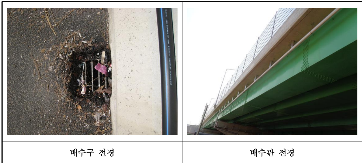
【사진 23.3.21】 배수시설 전경
